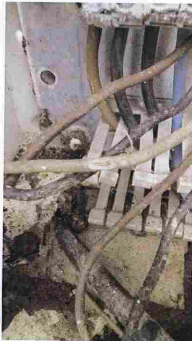
Imagen 7. Conductores de alimentación a motores en mal estado
