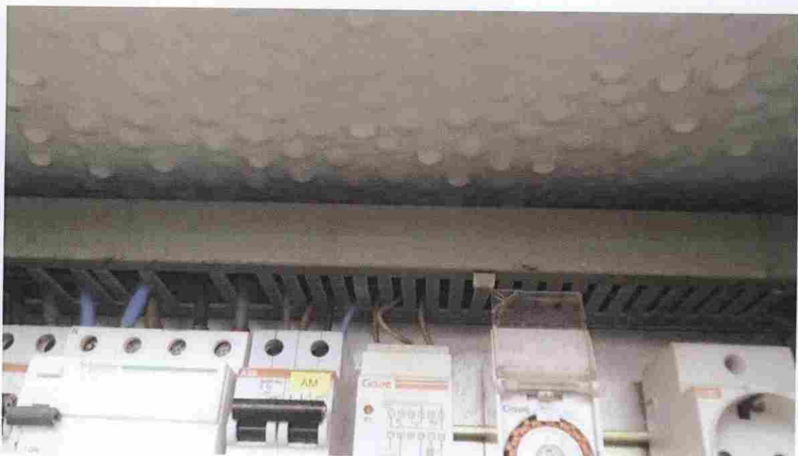
Imagen 8. Condensación interior cuadro de control de motores
